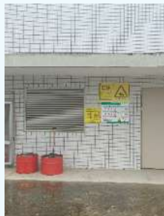
有害廢棄物倉庫
