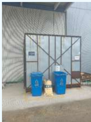
一般廢棄物倉庫
