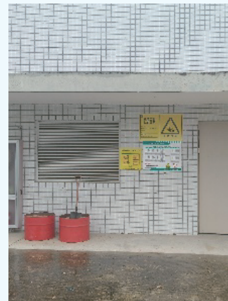
有害廢棄物倉庫
